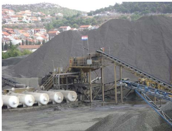
Slika 2. Postrojenje za razdvajanje frakcija 0/5 i 5/25 mm i izdvajanje manganskih legura iz krupne frakcije
